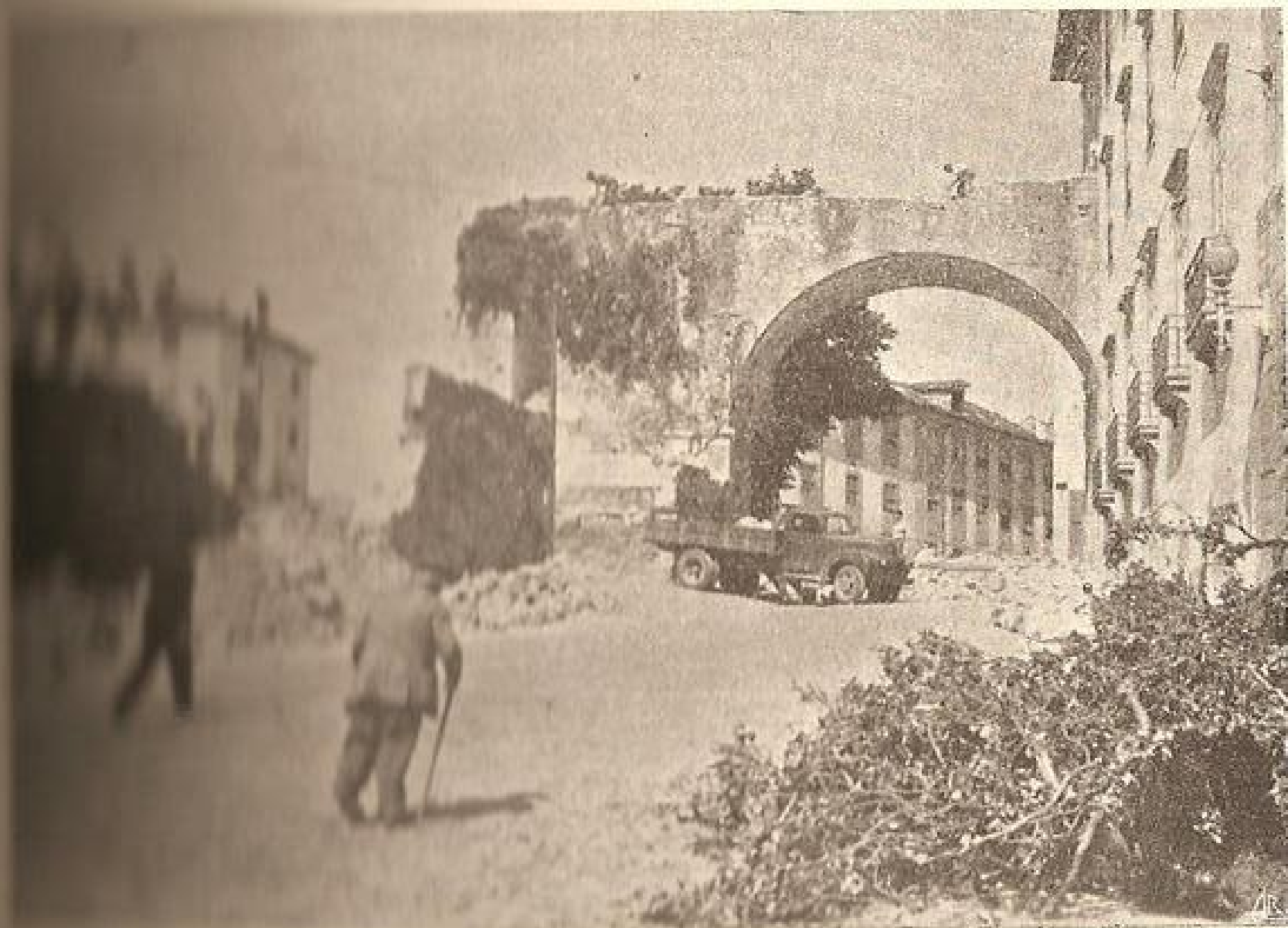
O Arco do Castelo, visto do lado da Ladeira do Liceu, quando se procedia à sua demolição.
